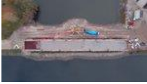
Beton storten Rondje Weerwater Persfoto.jpg 1.5 MB
